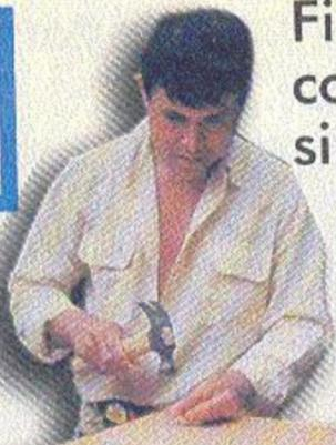
Fije la cubierta primero con un clavo de 2 pulgadas sin cabeza en el centro de cada pata y luego clave otros a lo largo de las chambranas (tenga cuidado de no clavar fuera de ellas).
