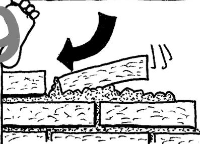
Para colocar el ladrillo es conveniente seguir un movimiento deslizante como indica el dibujo.
