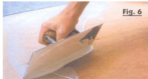
Aplicación del adhesivo para alfombra con llana metálica ranurada.
