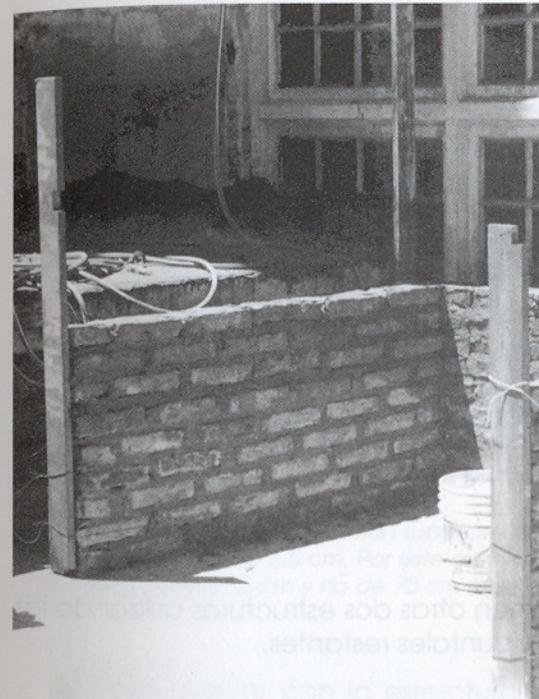
5) Para poder realizar la base donde se asentará el horno de barro, deberán fabricar una estructura de sostén interna.
