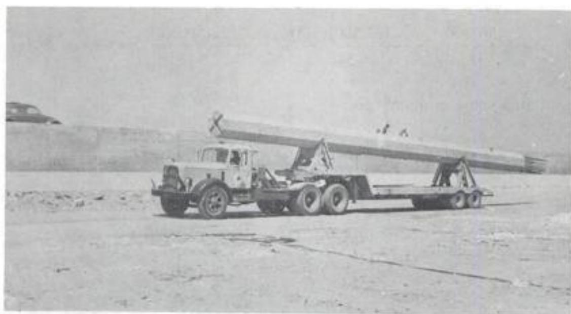
**Figura 27.30b** Transporte de pilotes.
