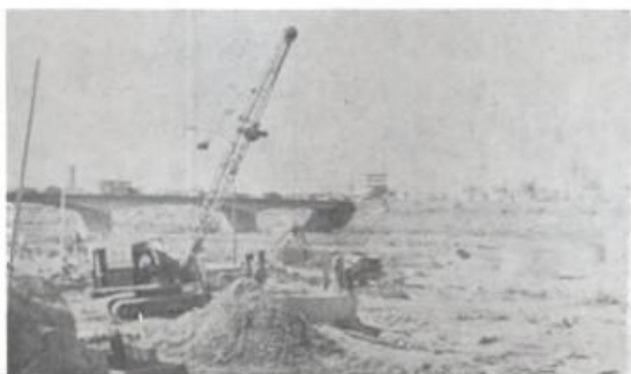
**Figura 29.17g** Extracción del material del interior del cilindro para que penetre por su propio peso.
