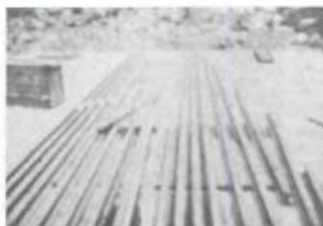
**Figura 32.1c** Instalación de las nuevas bases para recibir el edificio al ser movido hacia atrás, e instalación de los rieles sobre los que se efectuó el movimiento.
