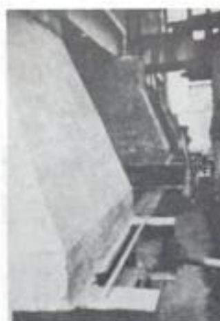
**Figura 32.1g** Vistas parciales del edificio mostrando parte de las instalaciones para efectuar el movimiento, así como los pedestales de concreto y las viguetas de acero vistos más de cerca.
