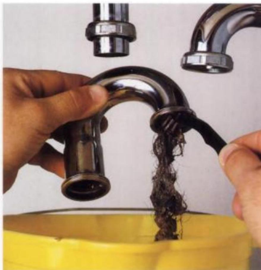
**2** Vaciar los desechos. Restregar con cepillo el interior del acodamiento. Cambiar el acodamiento si hay corrosión (página siguiente.) Ensamblar de nuevo la trampa; apretar las tuercas con llave de canal, pero no apretar demasiado. Probar el desagüe con agua. Si hay fuga en el desagüe, apretar las tuercas con otro cuarto de vuelta.
