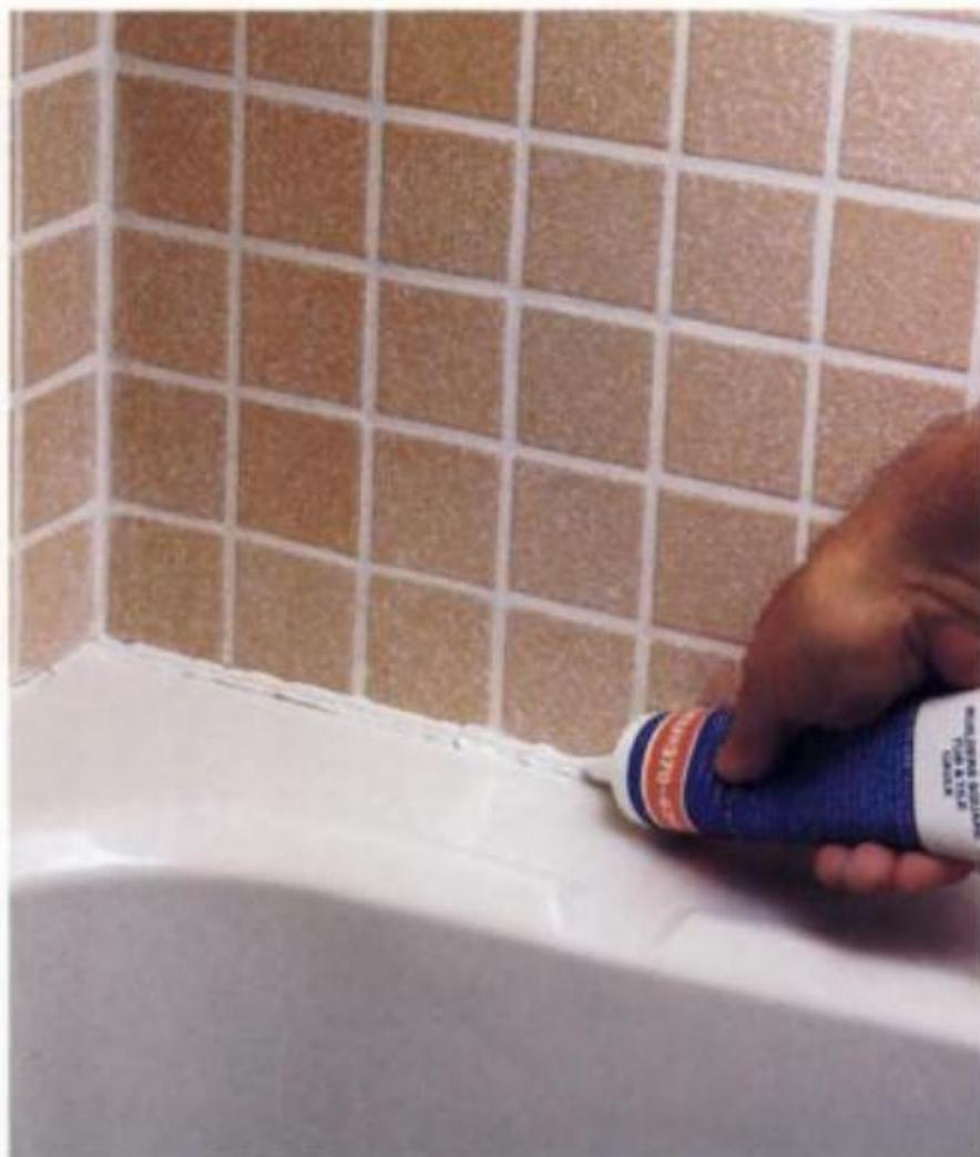
**2** Llene la bañera para que tenga el peso suficiente y se desplace hacia abajo de la línea de azulejos. Calafatee la junta con silicio o de látex de buena calidad para que no se vuelva quebradizo.
