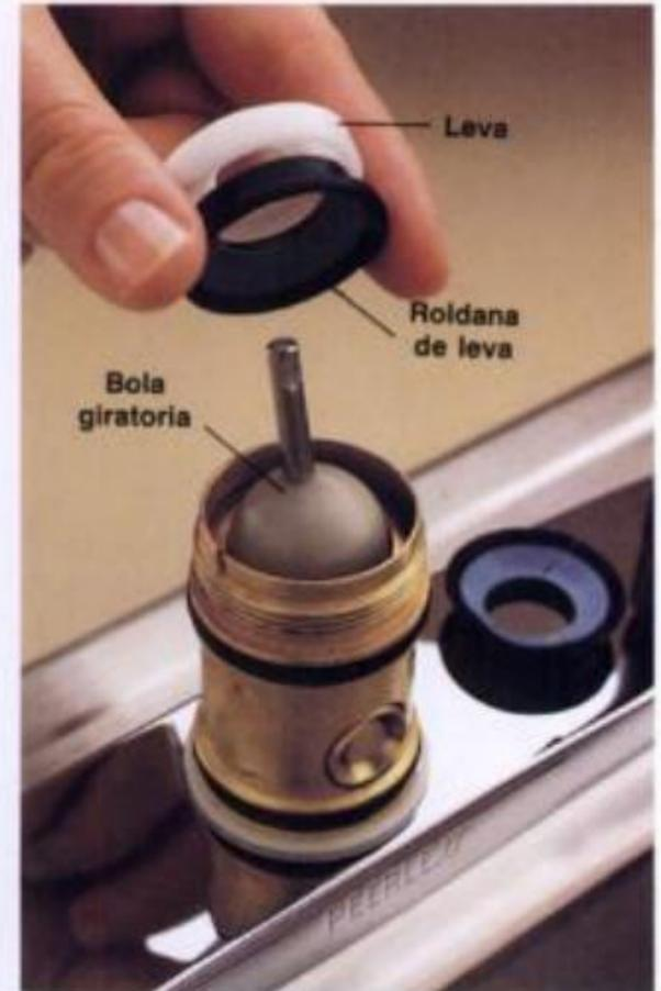
**3** Desenroscar la tapa con pinzas ajustables. (Cubrir las mordazas de las pinzas con cinta de plástico o con tela gruesa para no rayar la superficie de la tapa.) Alzar la leva, la roldana de leva y la bola giratoria.
