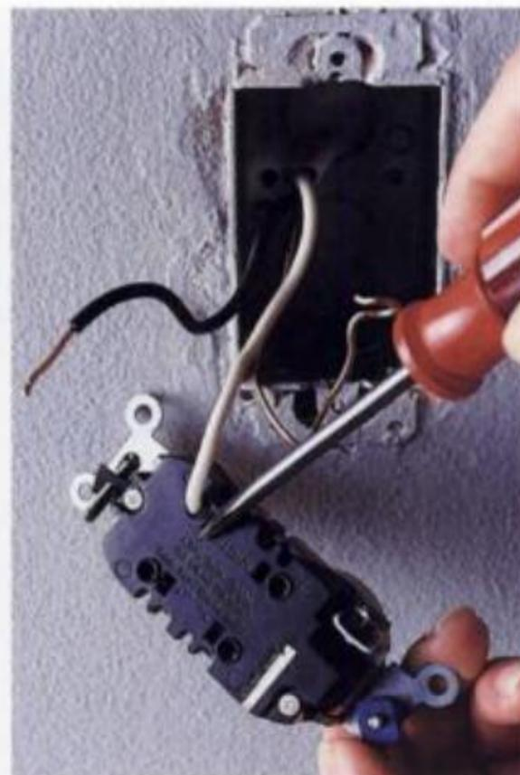
**3** Inserte las punta de un destornillador pequeño hacia adentro de la ranura de liberación para soltar las conexiones de presión; o afloje las terminales roscadas para quitar el enchufe de los cables.
