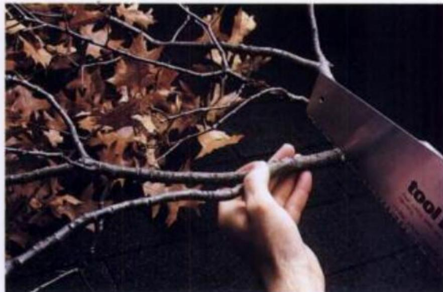
**Cortar las ramas** con una sierra para podar para evitar el desgaste de los materiales del techado y para que aumente la luz del sol que recibe el techo. La mayor cantidad de luz solar seca la cubierta y termina con el musgo y el moho.
