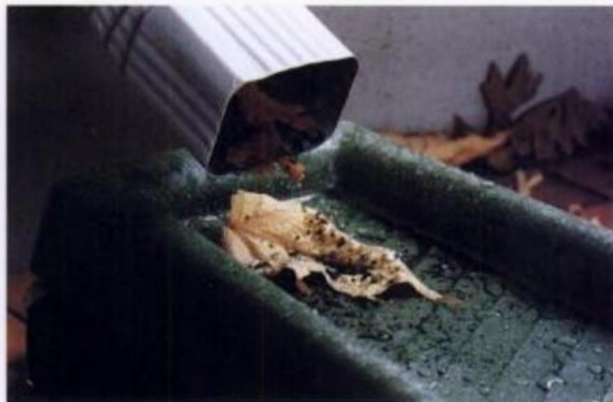
**La grava en los canales de descenso** o en los canalones de lluvia indica que hay desgaste en la superficie de las tejas. Probablemente pronto sea necesario cambiar el techado.
