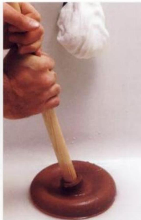
**En bañeras** con palanca de disparo o tapones retráctiles de desagües, quitar los tornillos de la tapa de derrame y jalar cuidadosamente el mecanismo elevador para sacarlo de la abertura de derrame. Quitar el tapón del mecanismo retráctil. Tapar la abertura de derrame con trapo mojado antes de bombear el desagüe.
