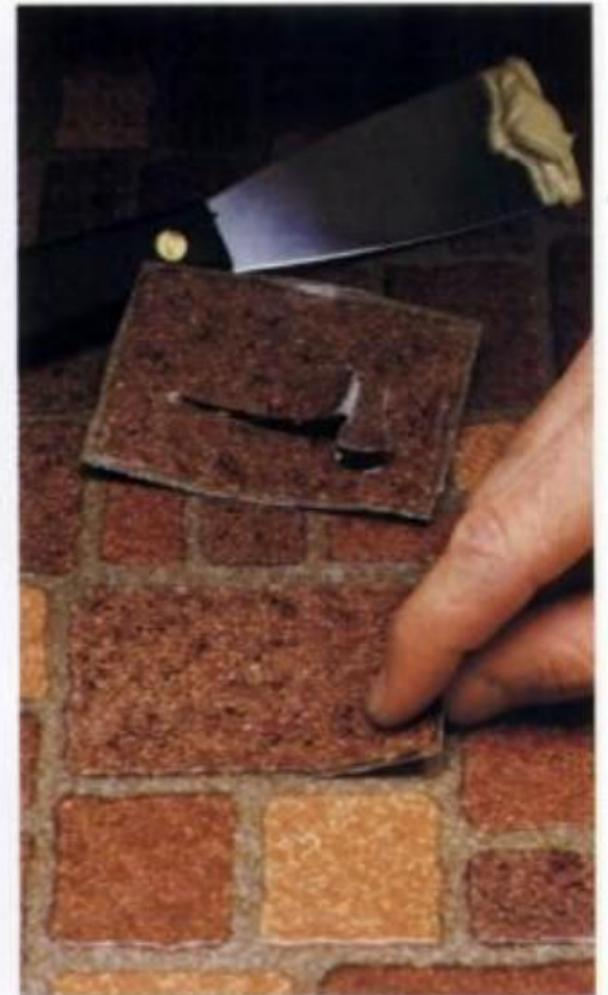
**3** Aplique soluciones minerales para disolver el adhesivo; después limpie con espátula de vidrio o con un raspador tipo rastrillo. El nuevo adhesivo se aplica al fragmento de reemplazo y se adapta dentro de la cavidad. Se pasa el rodillo sobre el vinilo para aplanarlo y que quede bien pegado. Quite el adhesivo sobrante.
