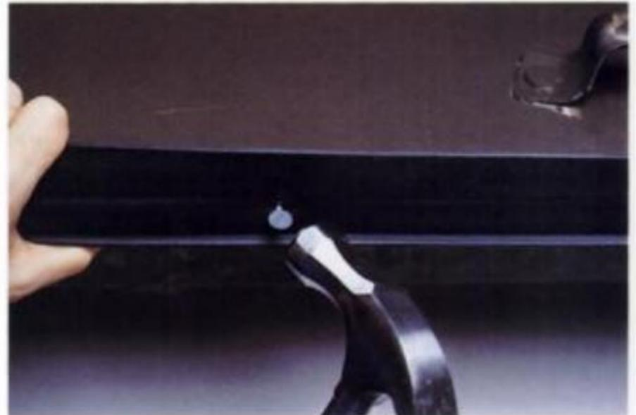
**2** Corte el nuevo gualdrín a la medida de la puerta. Clave la tira a la parte inferior de la puerta. Utilice clavos galvanizados resistentes a la corrosión.
