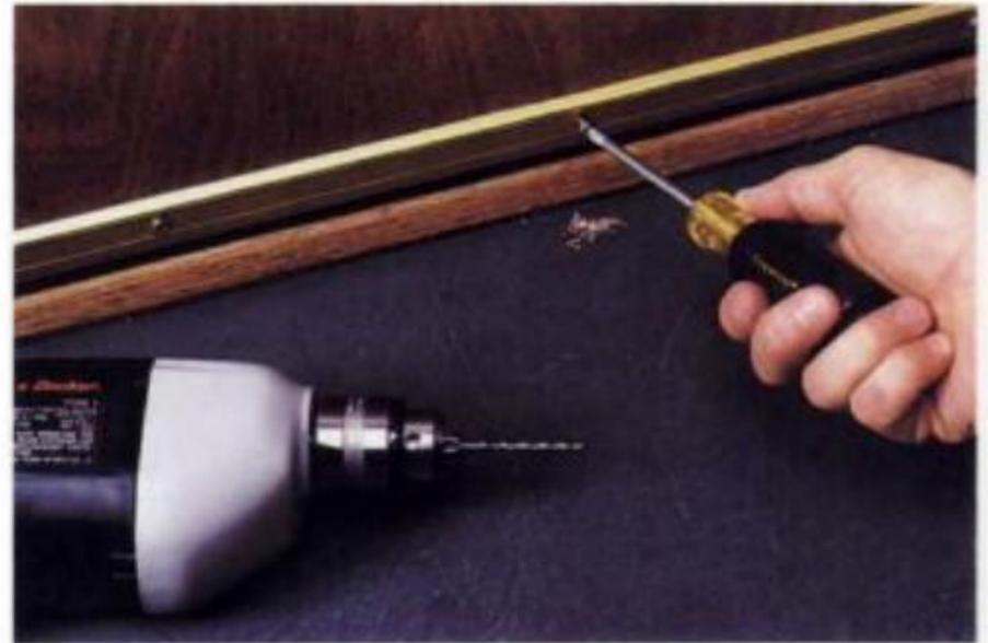
**2** Taladre barrenos piloto para los tornillos; después fije con tornillos la tira en el interior de la puerta para que el fieltro o vinilo selle la abertura debajo de la puerta. Las perforaciones ovaladas permiten efectuar el ajuste necesario.
