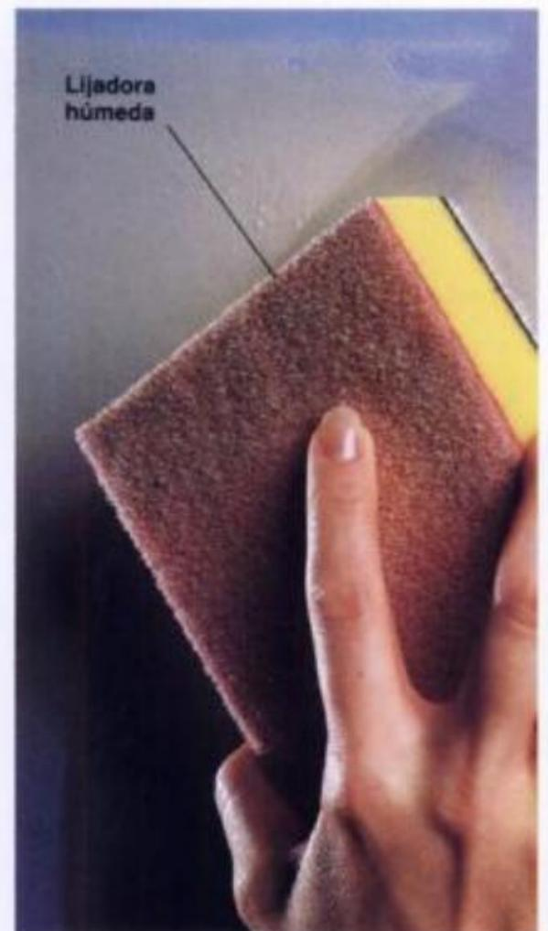
**6** Aplique una segunda capa de compuesto. Una vez que esté seco se pule ligeramente con lijadora húmeda o lija común para alisar el remiendo. Retoque la pared.
