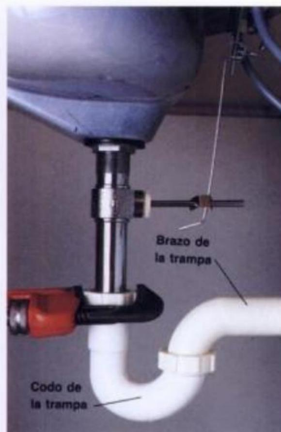
**3** Cambiar la posición del brazo de la trampa en la pared para alinearlo con el extremo corto del acodamiento de la trampa. Apretar todas las tuercas con pinzas ajustables o llave para tubos, pero no apretar demasiado. Probar el desagüe con agua. Si hay fuga en el desagüe, apretar las tuercas corredizas con otro cuarto de vuelta.
