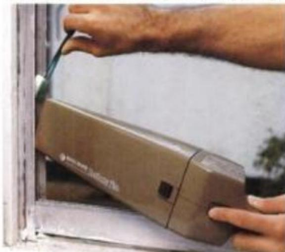
**Limpiar las carrileras** de puertas y ventanas corredizas con aspiradora manual y un cepillo para dientes usado. Es común que se acumule la mugre en las carrileras de guardaventanas.
