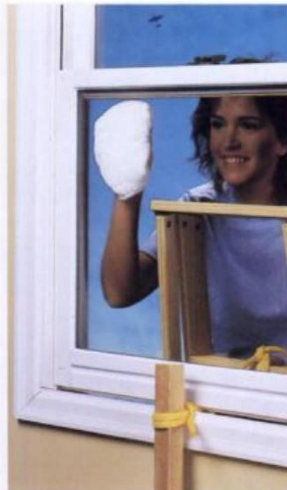
**Anclar la escalera.** El peldaño superior se sujeta con un tramo corto de madera y cuerda. Se abre la ventana para colocar el bloque de madera adentro; después se cierra la ventana.
