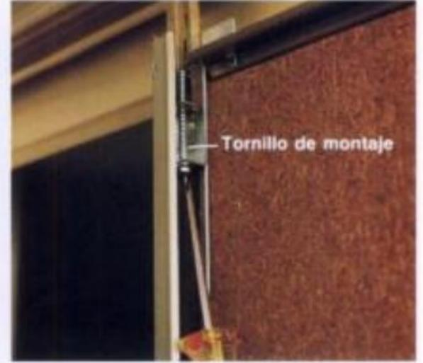
**3** Examine el hueco a lo largo del borde interior de la puerta para verificar que esté parejo. Para nivelar esta abertura, se gira el tornillo de montaje para alzar o bajar el borde.
