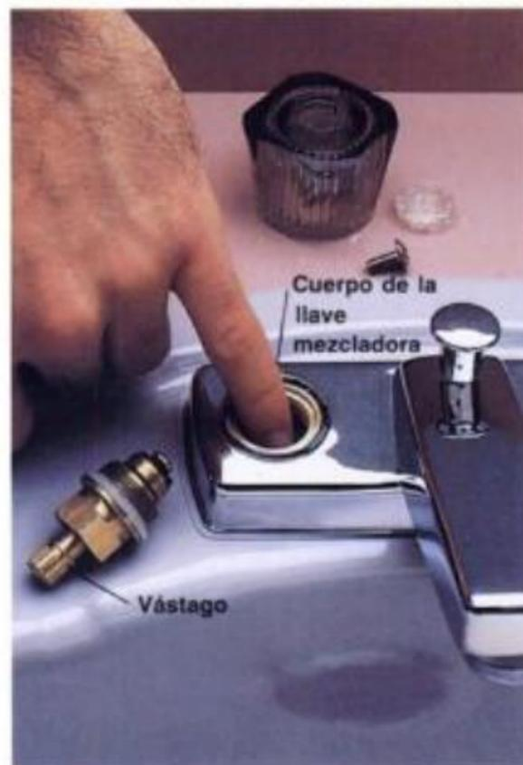
**1** Las fugas persistentes probablemente indiquen que un asiento de válvula del interior del cuerpo del grifo se encuentra dañado. Quitar el vástago de la espita y tocar el asiento de válvula con la punta del dedo índice. Si se siente áspero, cambiar el asiento, o reafinarlo con herramienta reafinadora de asientos (a la derecha).
