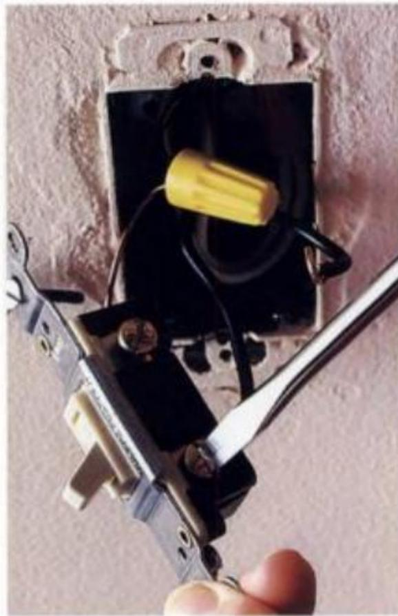
**4** Marque con cuidado los puntos donde se conectan los alambres al interruptor. Suelte los alambres para separar el interruptor.
