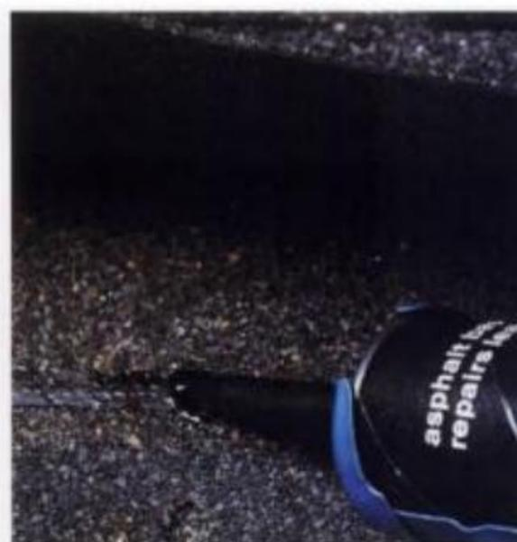
**Cubrir las cabezas de clavos** con mástique para techos para evitar goteras después de haber cambiado las tejas.
