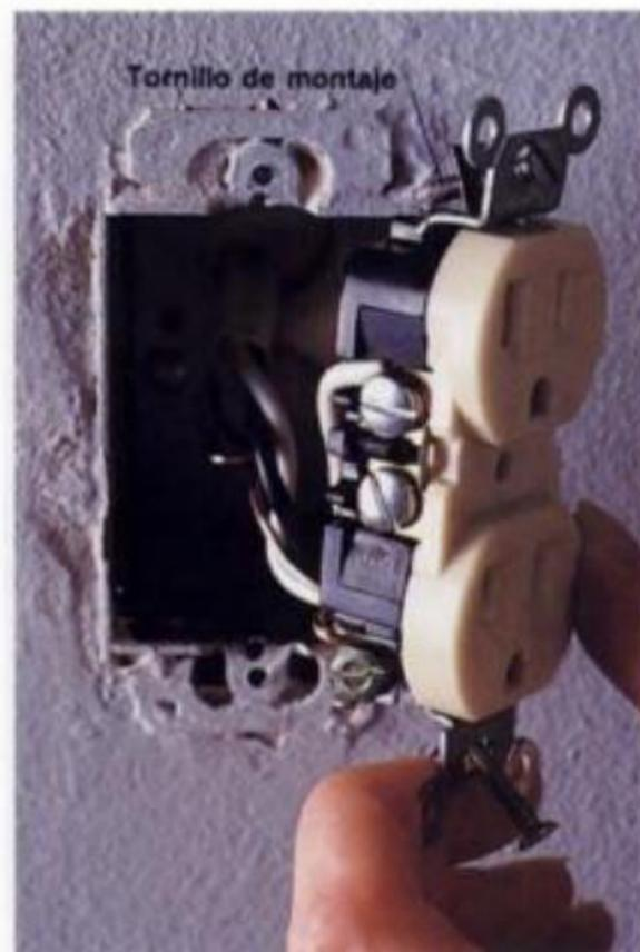
**6** Monte de nuevo el contacto dentro de la caja, para lo cual se introducen con cuidado los alambres. Apriete los tornillos de montaje y coloque la tapa protectora.
