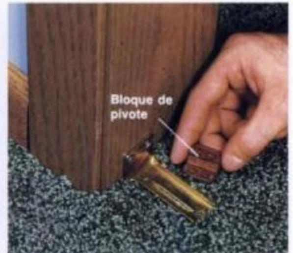
**Los bloques ajustables de pivote** también se localizan en la parte inferior de algunos modelos de puertas. Ajuste el bloque de pivote hasta que la separación entre la puerta y el marco sea pareja.
