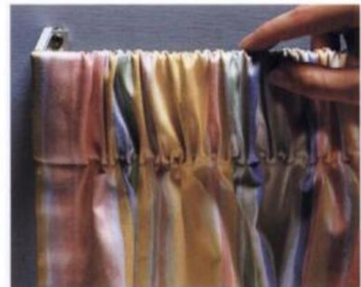
**1** Cuando no haya pie derecho de pared, utilice tornillos Grip-It® para colgar cortinas de peso medio. Se requieren: cortineros metálicos y juego de tornillos Grip-It.
