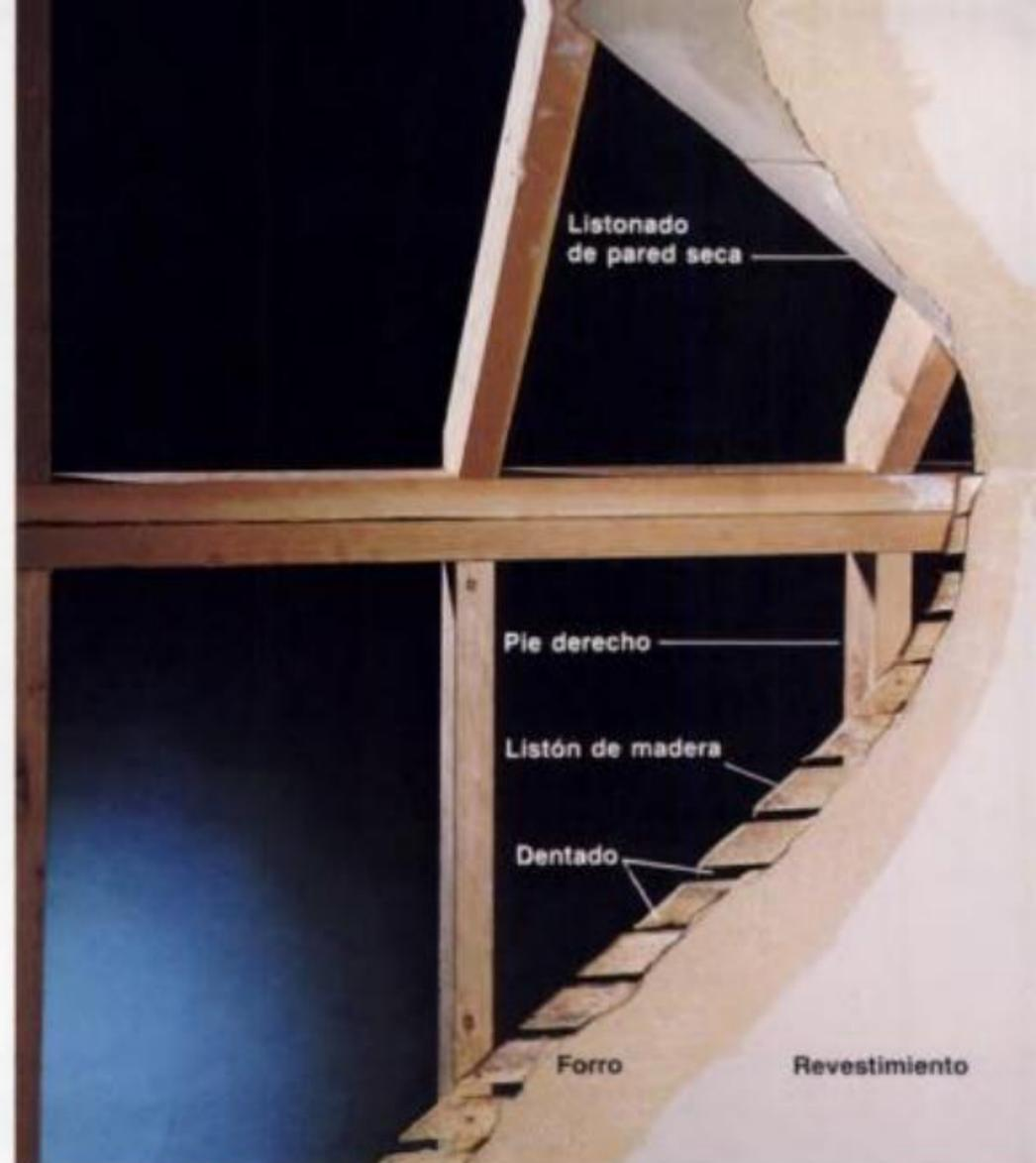
**Paredes de yeso prefabricadas**, conocidas también como muro seco, en la construcción de éstas se usan paneles de yeso fijados con clavos o tornillos directamente al bastidor. El espesor varía de  $\frac{1}{4}$ " a  $\frac{5}{8}$ ". Los pies derechos o vigas detrás de la pared de yeso por lo general se localizan a intervalos de 16" o 24", medidos de centro a centro. Se pueden usar una amplia variedad de dispositivos de sujeción.
