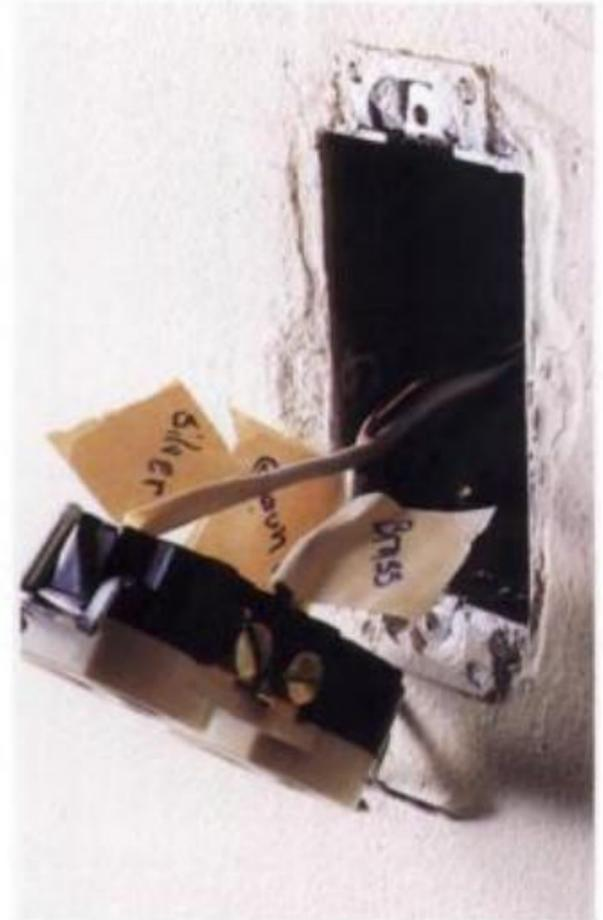
**Marcar los alambres** con pequeños marbetes de cinta para recubrir antes de desconectar un contacto o un interruptor. Los alambres se unen al nuevo enchufe o al interruptor según las marcas que tienen los marbetes.
