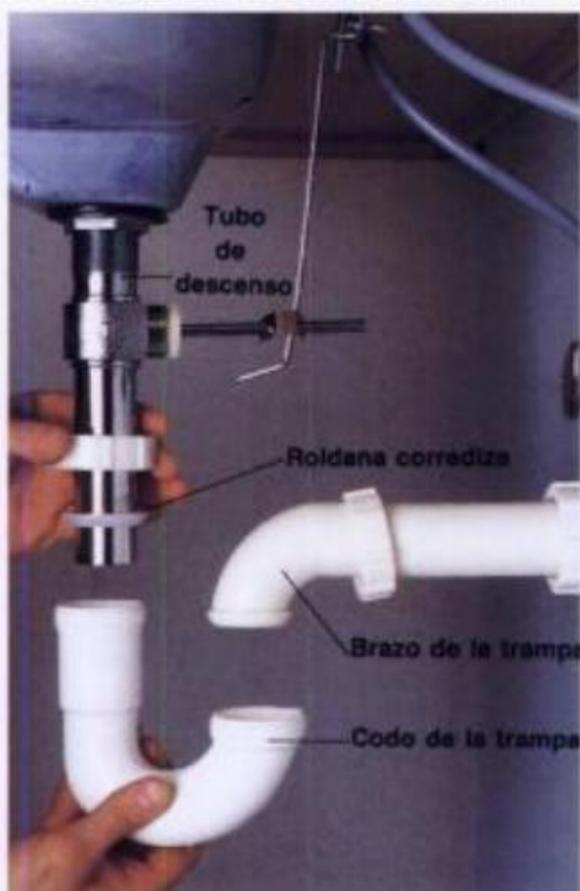
**2** Deslizar la tuerca corrediza por sobre el extremo del vástago roscado del grifo (cuerda hacia abajo), después una roldana (lado ahusado hacia abajo). Empujar el extremo largo del acodamiento de la trampa por sobre el extremo de vástago roscado del grifo y deslizarlo hacia arriba hasta que el extremo corto quede alineado con el brazo de la trampa. Deslizar la roldana y la tuerca hacia abajo del extremo de vástago roscada del grifo y apretarlos a mano por sobre el acodamiento.
