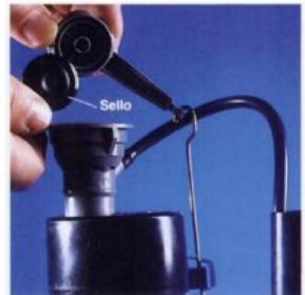
**3** Cambiar el asiento de válvula. Si el conjunto está demasiado desgastado, cambiar toda la válvula de admisión.
