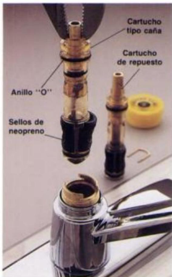
**4** Sujetar la parte superior del cartucho con pinzas ajustables. Jalar verticalmente para quitar el cartucho. Llevar consigo el cartucho usado para comprar la pieza de repuesto. Insertar el cartucho nuevo e instalar el seguro de retención.
