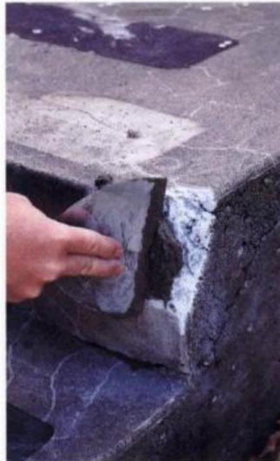
**2** Mezcle el resane para concreto con agua; después, vacíelo en el líquido adhesivo, según las instrucciones del fabricante. Aplíquelo en el área en reparación con una espátula flexible o con llana metálica.
