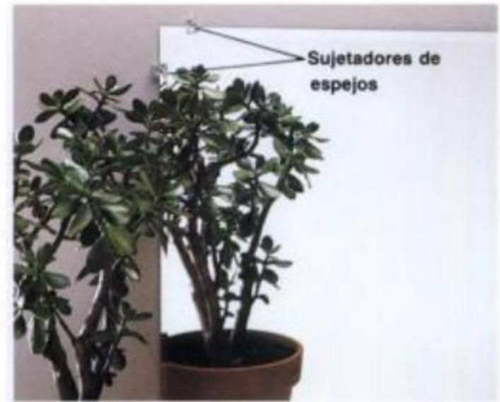
**1** Para fijar un espejo ligero en la pared ponga dos sujetadores en cada esquina. Se requieren sujetadores para espejos, anclas de plástico, taladro y broca.
