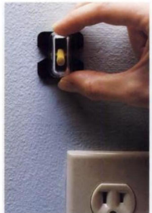
**Use un detector magnético o electrónico** para localizar clavos de acero. Pase al azar el detector sobre la pared hasta que el imán indique la presencia de un clavo en un pie derecho.
